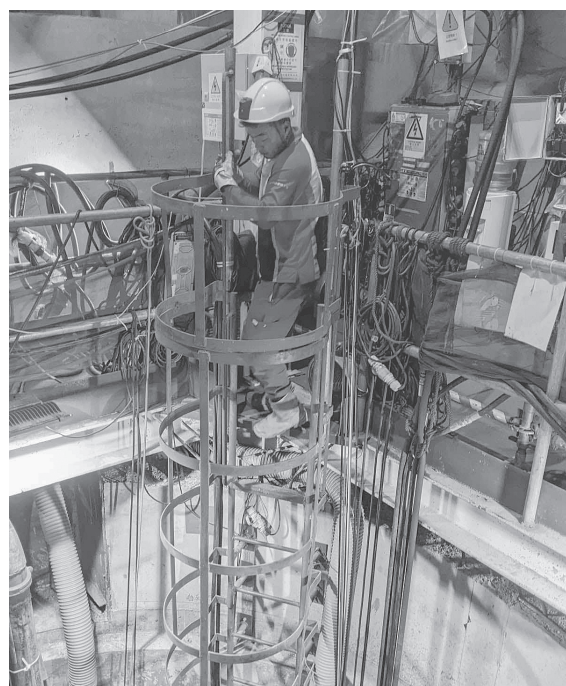
図10 スマートヘルメットをかぶって 地下トンネル工事現場で作業する様子
